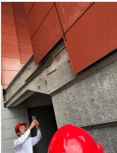
Hình 8. Tấm xi măng sợi đã sơn trang trí bề mặt được ốp bên ngoài tòa nhà
